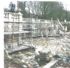
Le nymphée fait aussi l'objet de travaux de rénovation.
