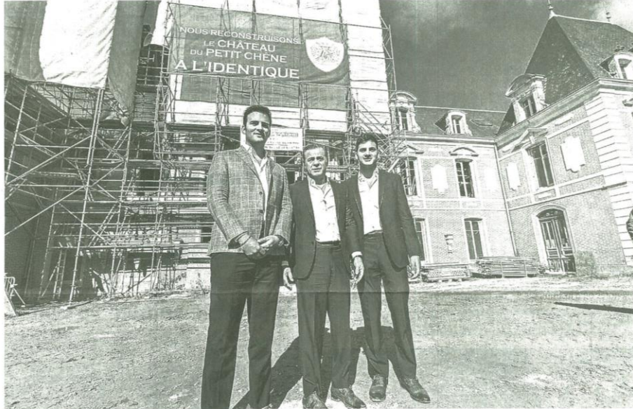
Mazières-en-Gâtine, hier. Zaya Younan, avec ses fils David et William, a assisté à une réunion de chantier au château du Petit-Chêne. Photo Dari.
