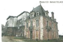
Un incendie a complètement détruit l'aile gauche et la moitié du corps principal du bâtiment. Il y a un an.
