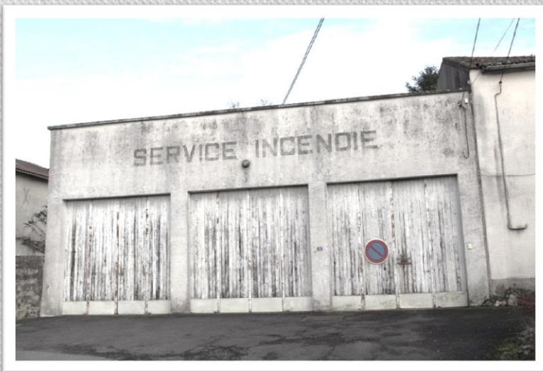
Ancien local des pompiers
