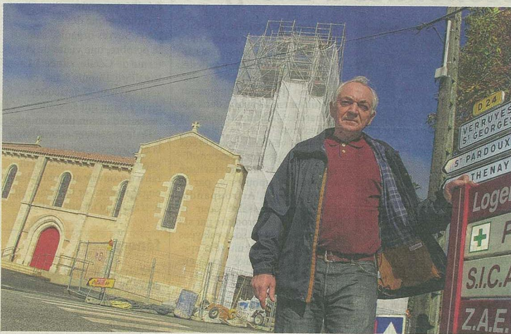
Claude Largeau, adjoint en charge des travaux, devant l'imposant chantier de l'église.
