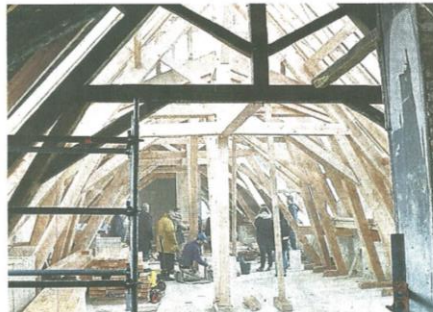
Une telle charpente représente quelque 80 m 3 de bois.
