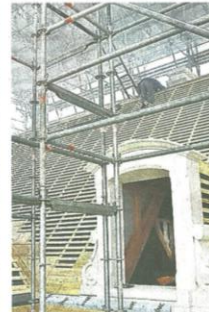
La toiture fait peau neuve.
