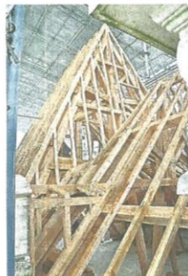
La charpente vue du dessus.
