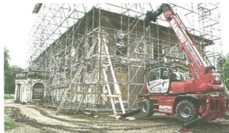
Depuis l'incendie, l'aile droite du château a été totalement vidée de ses débris et un échafaudage a été installé afin de protéger le bâtiment.
